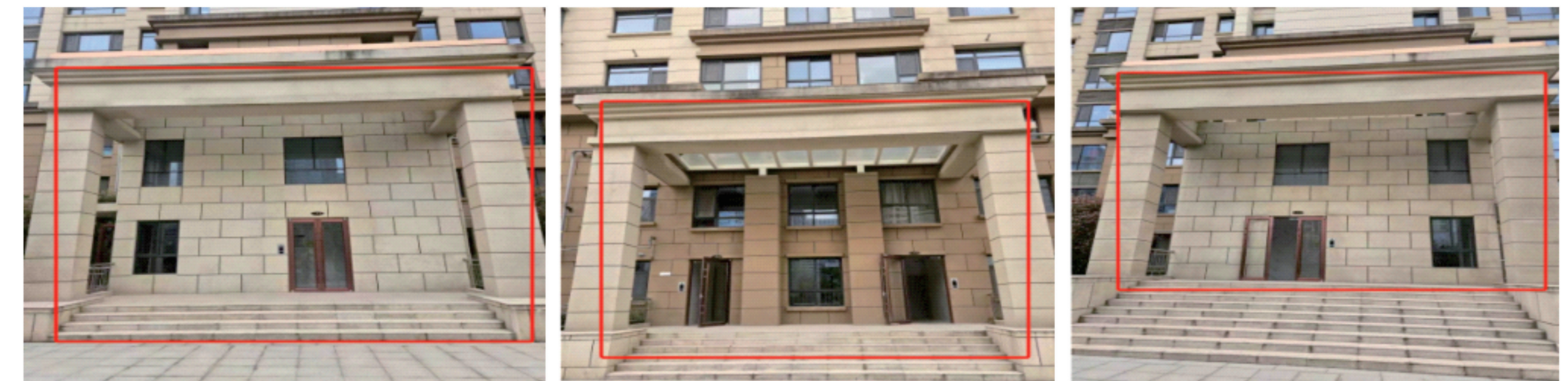
1#楼A、B、C单元增设三处门廊
